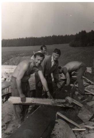
Zděňa hrubým prknem „hladí“ beton... staví se garáž..
